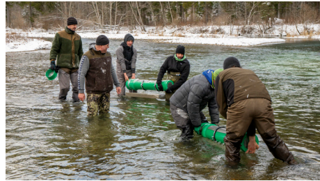
Verankern der Röhrenboxen in der eisigen Unteren Ammer
