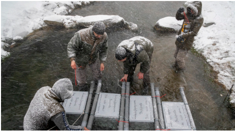
Bei jedem Wetter: Installation der Ulmer Boxen im Umgehungsgerinne an der Oberen Ammer
