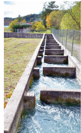
Fischleiter an der Isar- Wehranlage Krün
